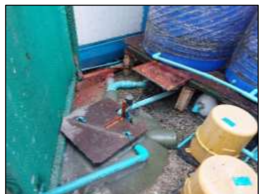
ภาพที่ 18 ถังบำบัดน้ำเสียสำเร็จรูป
