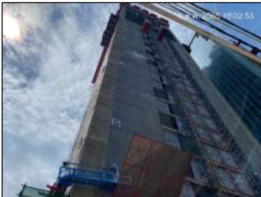
ภาพที่ 6 Mesh Sheet ปิดคลุมอาคาร
