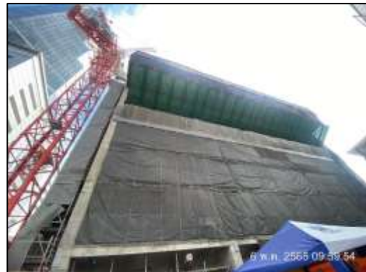
ภาพที่ 6 Mesh Sheet ปิดคลุมอาคาร
