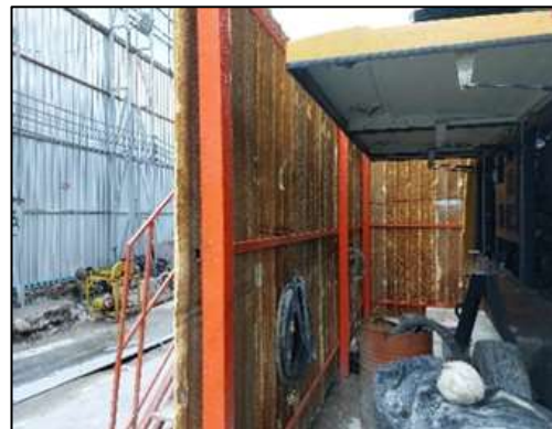
ภาพที่ 8 ม่านละอองน้ำบนโครงสร้าง Metal Sheet
